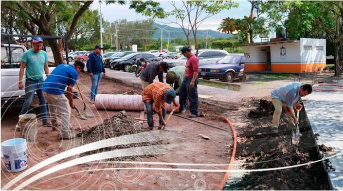
Se realizó la instalación de la iluminación en el Cementerio Municipal y Paseo de la Misericordia, retirando la instalación antigua y metiendo tubería metálica para cableado, así como cable nuevo y luminarias de mejor calidad. Se colocaron contactos en puntos estratégicos, pasillo central y frente de este, invirtiendo la cantidad de \$140,000.00 (ciento cuarenta mil pesos 00/100 m.n) en todo el material, beneficiando la seguridad por las noches y en las periferias del cementerio.
