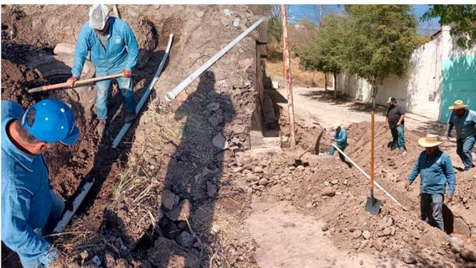
Se logró la ampliación de red de agua potable en el Callejón del Ozote, con una cantidad de 200 metros de tubería de PVC hidráulico RD 26 de 2.5” , esto para abastecer las necesidades de los vecinos de dicho domicilio y parte de la Calle 20 de noviembre en el cerrito. El monto de inversión de esta obra es de \$40,000.00 (cuarenta mil pesos 00/100 m.n), beneficiando a 20 casas.
